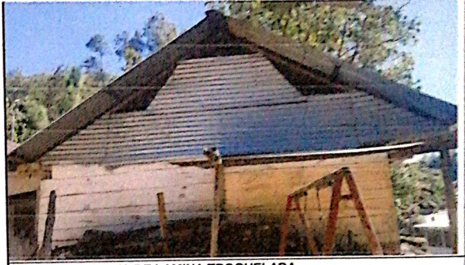
FOTO 2: CUBIERTA DE LAMINA TROQUELADA
